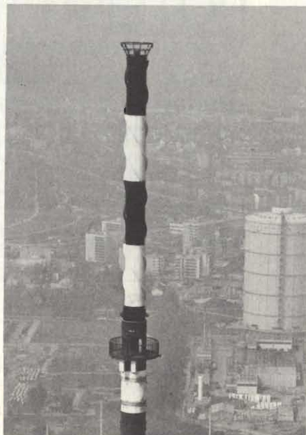
Fig. 1. Cilindro in vetroresina munito di spirale Scruton (foto Kathrein)
